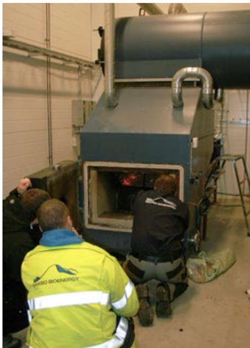
Kontroll av brännkammaren.
