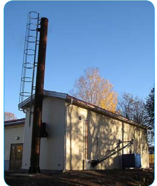
Designanpassad fasad för att passa omgivningen och övriga byggnader.
