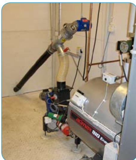
Pelletskruv och brännare.
