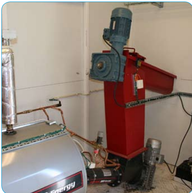
Bild på anslutningen mellan förråd och matarskruv.
