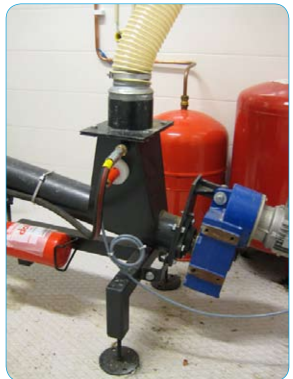
Fallschakt mot matarskruv.
