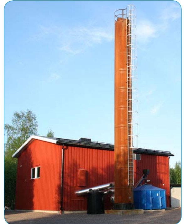
Vybild över anläggningen.
