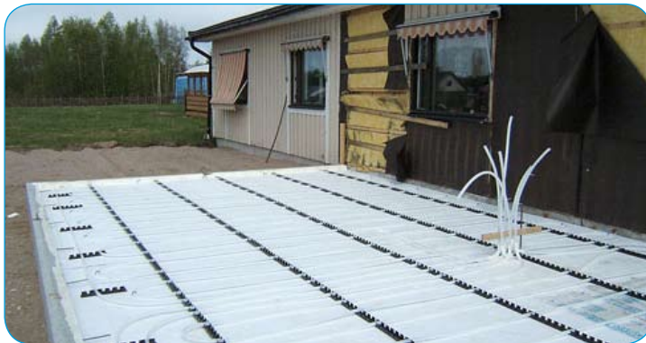
Golvvärmeslangen är utlagd på den nya grunden.
