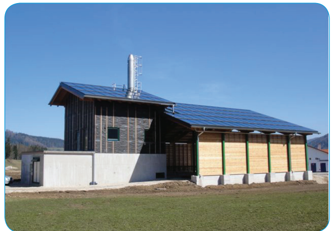
Pannrum med solpaneler på.
