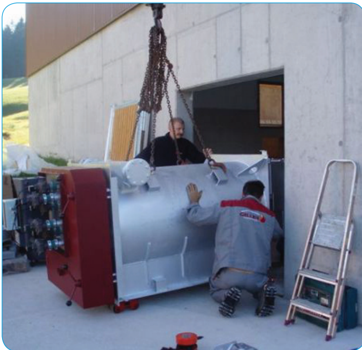
Pannans övre del förbereds att dras in i rummet.
