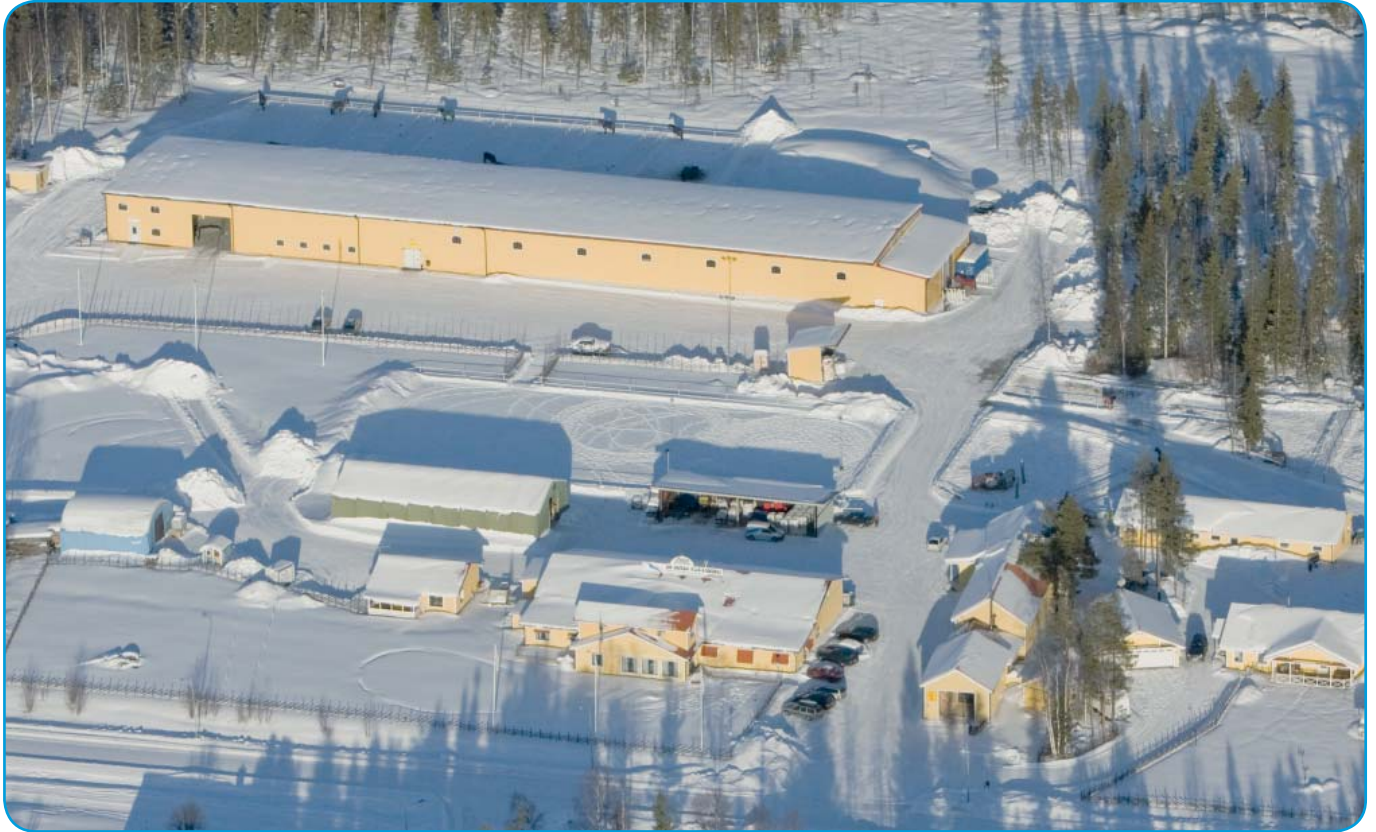
Flygbild över anläggningen i Boden.
