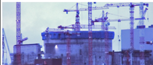
Nordisk Energi på besök i Finland där man nu bygger sitt femte kärnkraftverk
