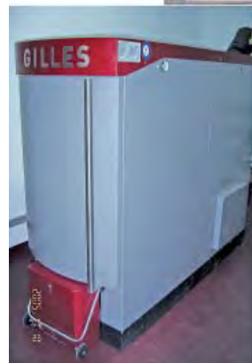
Industrianläggning HPK-RA 160 Gilles standardskruv 7 m
